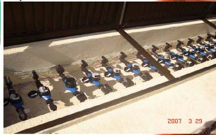
Laje de Cobertura
